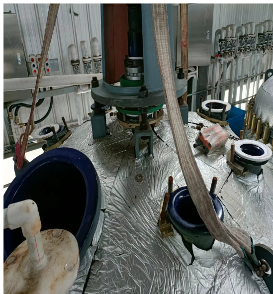
图六 2#反应釜法兰、人孔盖已拆
