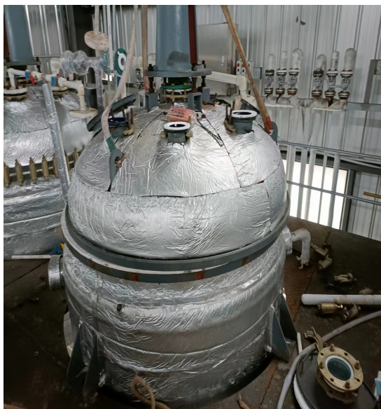
图五 2#反应釜螺栓已拆
